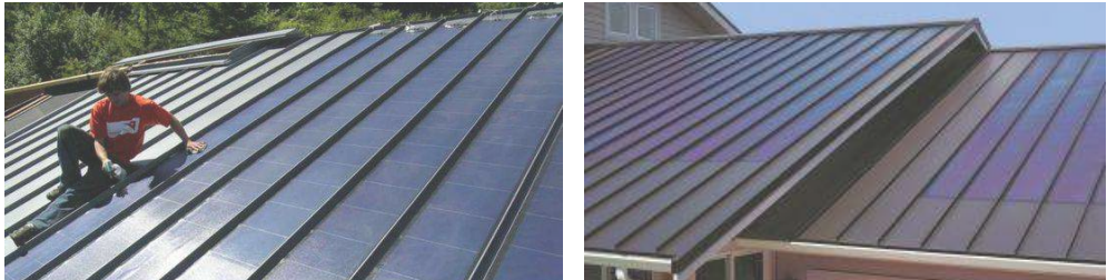
Alternatívna integrácia fotoclánkov do konštrukcie strechy
