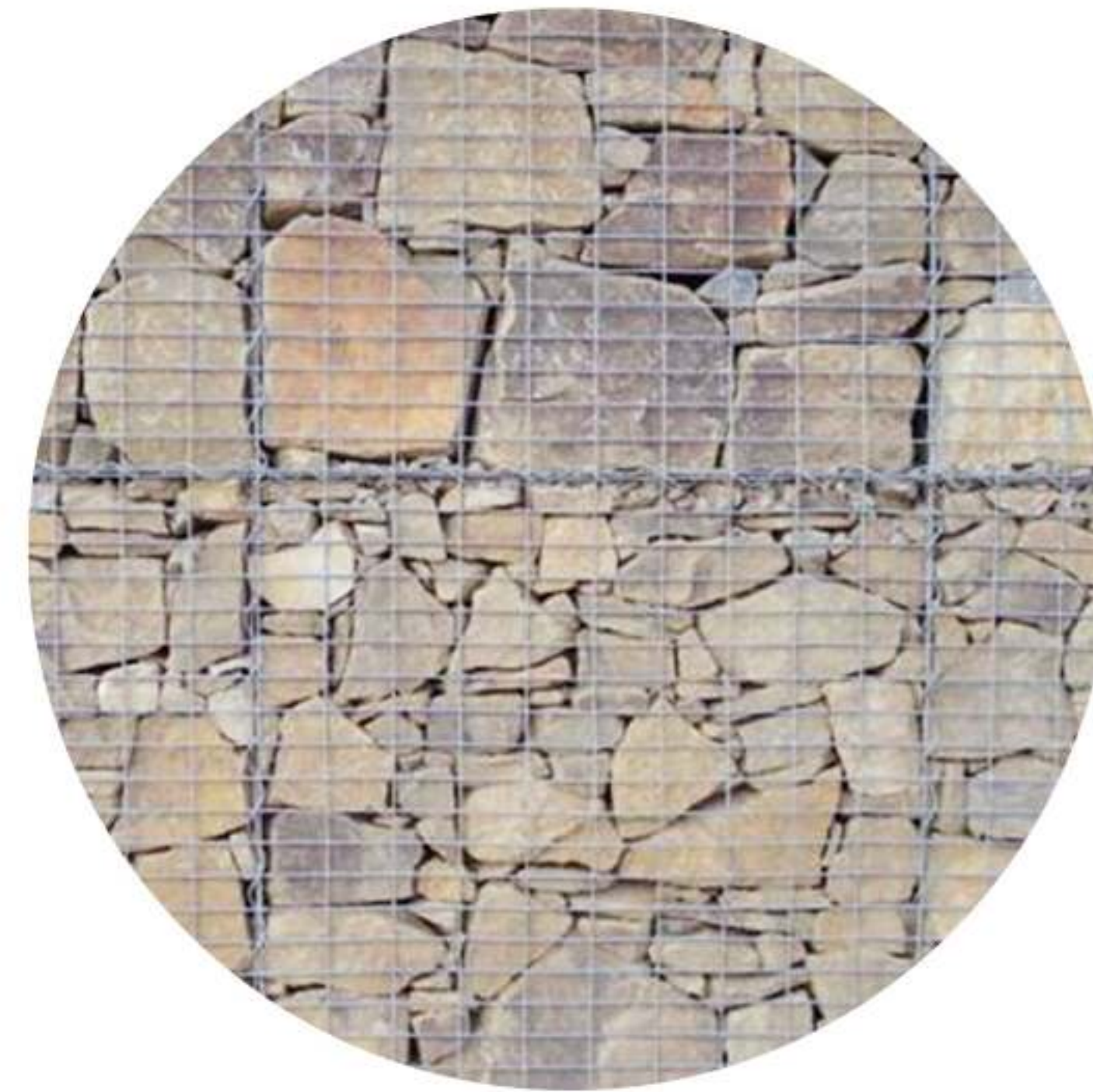
GABION S KŘEMENCEM
